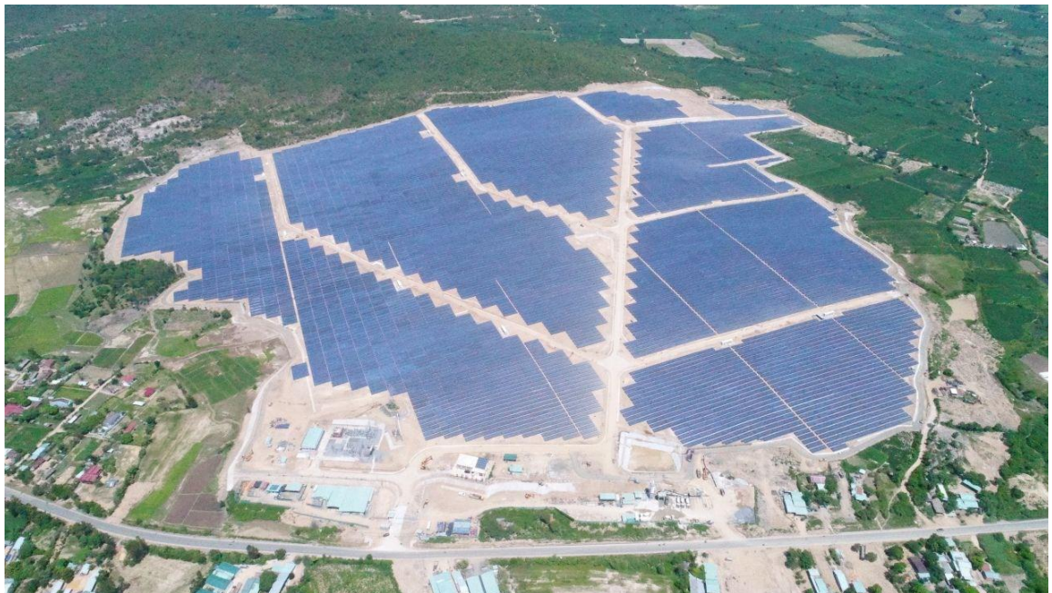
Hình 8: Dự án Krông Pa 69 MWp - Gia Lai
