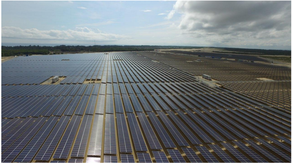
Hình 7: Dự án Phong Điền 48 MWp - Huế
