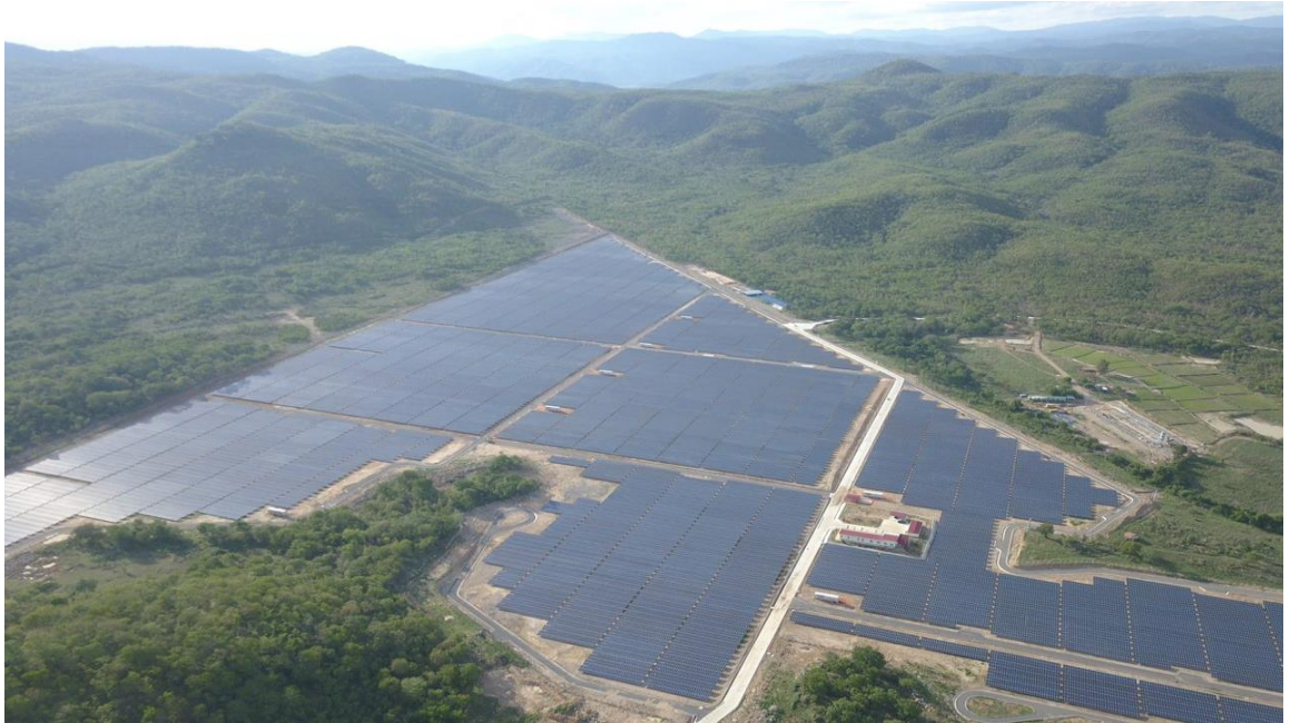
Hình 9: Dự án Hàm Phú 2 49 MWp - Bình Thuận
